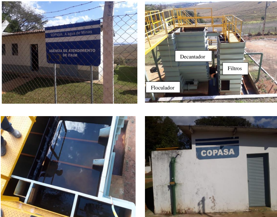
Figura 3.18 - Estação de Tratamento de Água de Itaim.
