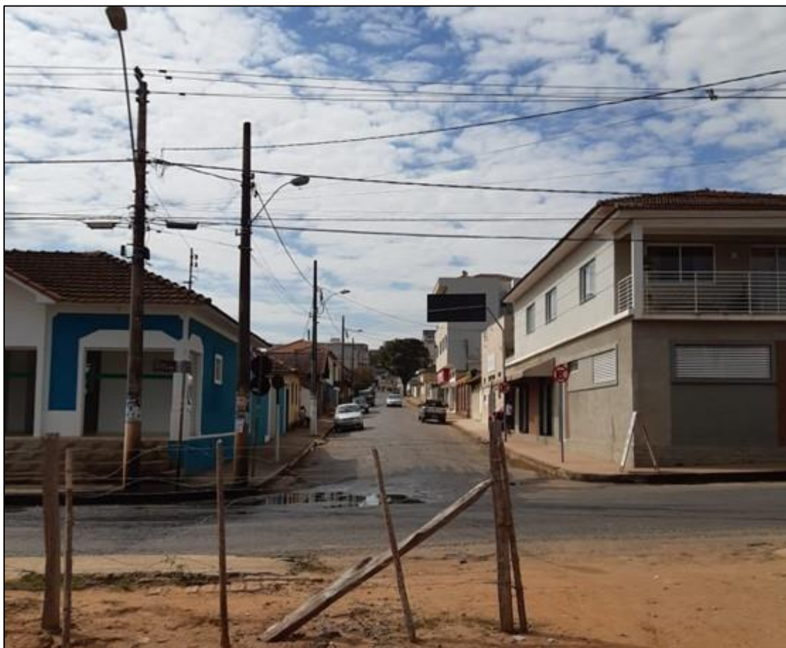
Figura 4.10 – Rua Bueno de Paiva, onde ocorrem transtornos durante as chuvas devido a drenagem pluvial superficial.
